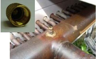
Сервисни вентили. Ако не се отстрани иглата на вентилот при лемење или, пак, ако настанало оштетување на гумените заптивки на вентилот. Сервисните вентили секогаш треба да се затворат со капаче кое има гумен или бакарен прстен како заптивен елемент.
