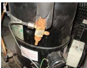
Вентили на висната и на потисната гранка на компресорите. Овие делови се подложни на корозија затоа што се изработени од челик. Тие можат да се оштетат при монтажа од прегревање при тврдо лемење<sup>1</sup> или, пак, при престегнување на елементите, ако се работи за раздвоен тип на врска.
