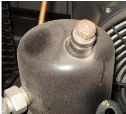
Сигурносни вентили. Ако системот работи со повисоки притисоци од нормално работните, може да дојде до пропуштање или до комплетно отворање на сигурносните вентили.
