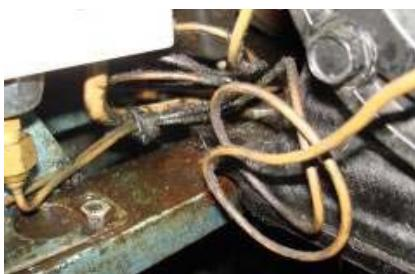
Капиларни цевки кај термоекспанзионите вентили. Кај капиларните елементи заради вибрации, механички оштетувања и сл.
