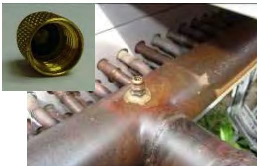
Сервисни вентили. Ако не се отстрани иглата на вентилот при лемење или, пак, ако настанало оштетување на гумените заптивки на вентилот. Сервисните вентили секогаш треба да се затворат со капаче кое има гумен или бакарен прстен како заптивен елемент.
