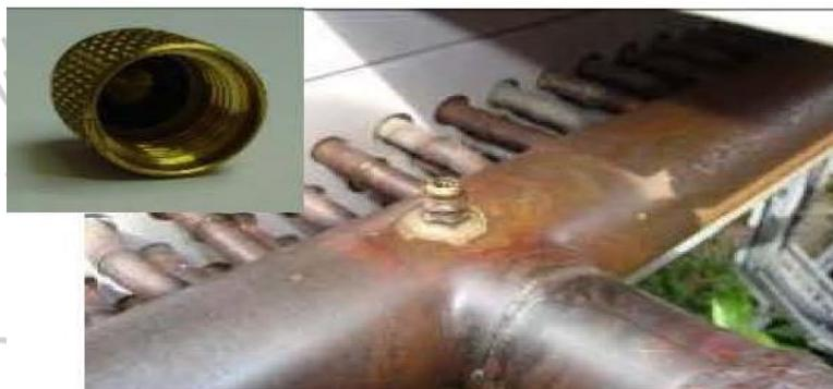
Сервисните вентили. Доколку не се отстрани иглата на вентилот при лемење или пак настанало оштетување на гумените заптивки на вентилот. Сервисните вентили секогаш треба да се затворат со капаче со кое има гумен или бакарен прстен како заптивен елемент.
