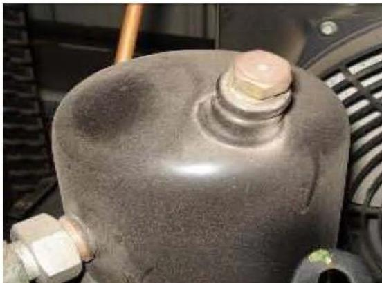
Сигурносните вентили. Доколку системот работи со повисоки притисоци од нормално работните, може да дојде до пропуштање или комплетно отварање на сигурносните вентили.
