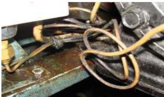
Капиларните цевки, термоекспанзионите вентили. Кај капиларните елементи заради вибрации, механички оштетувања и сл.
